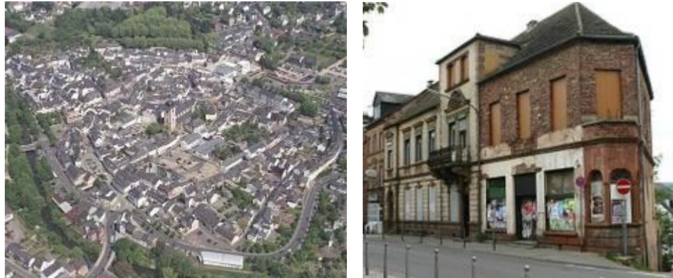
Luftbildaufnahme der Altstadt Wittlich und Sanierungsbedarf in der Schloßstraße (Quelle: Stadtverwaltung Wittlich)
