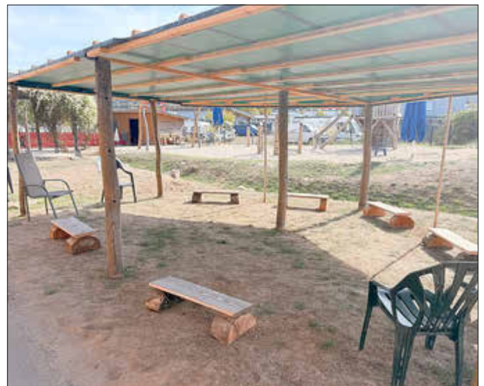
Eines der fertigen Dächer mit neuen Sitzbänken
