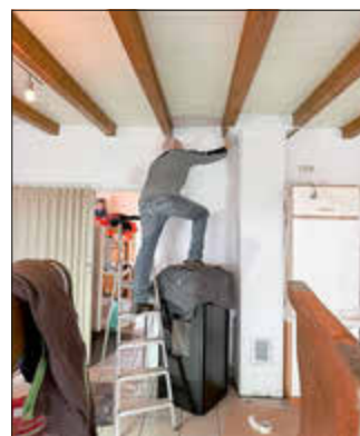
Während der Renovierung.
