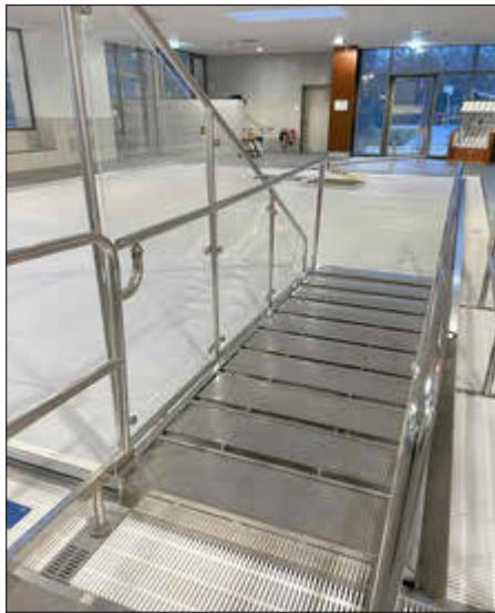
Variobecken während der Entleerung: Der Boden wird hochgefahren, darunter befindet sich das Wasser, das aktuell abgepumpt wird.
