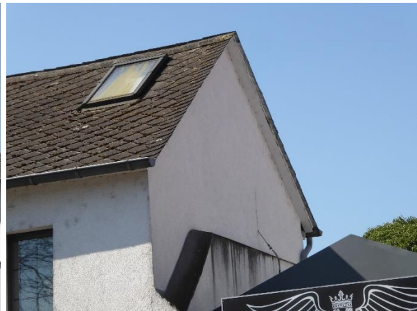
Abb.: Dachfenster im Kunstschieferdach Abb.: dichter Abschluss an Nordgiebel
