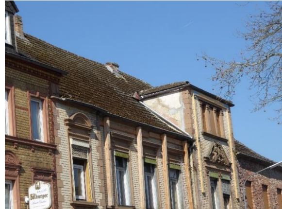
Abb.: Dohle und Löcher im Ziegeldach Abb.: ungeeignetes Betonziegeldach
