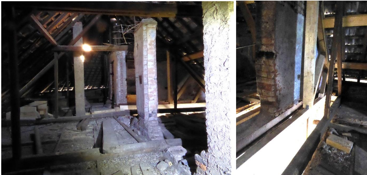
Abb.: Blick in den oberen Dachbodenbereich Abb.: Balkensicherung am Gebälk
