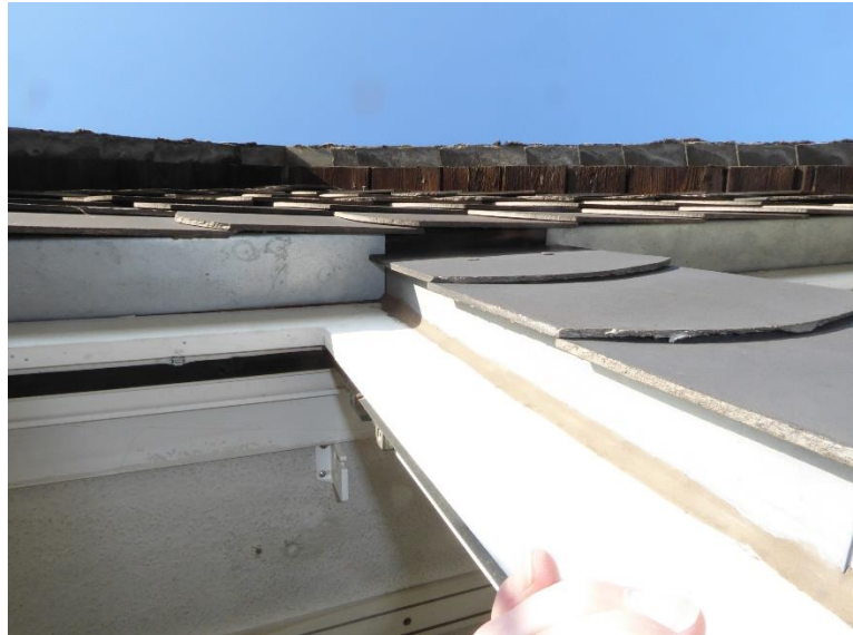
Abb.: anderer Giebel im Dachboden Abb.: Kunstschiefereindeckung an Gaube
