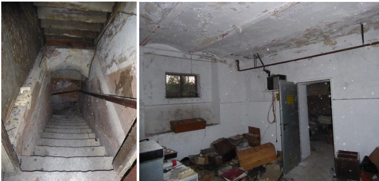
Abb.: Treppenabgang zum Keller Abb.: Kölner Decke in Lagerraum im Keller
