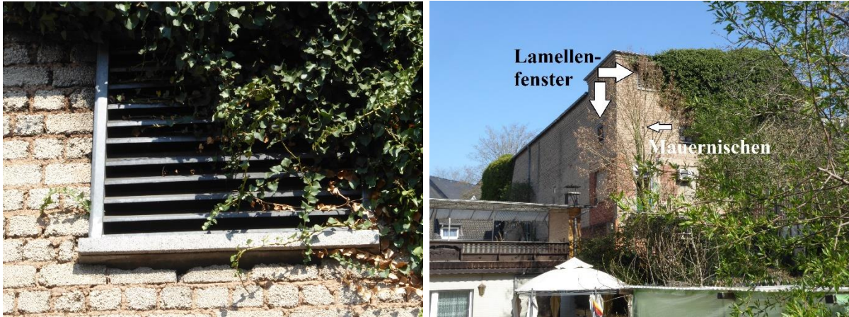
Abb.: Lamellenfenster auf Südseite Abb.: Lamellenfenster und Mauernischen
