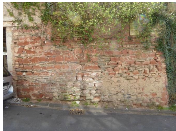
Abb.: Bruchsteinmauerwerk mit Spalten Abb.: alte Hangmauer mit tiefen Fugen
