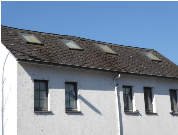
Abb.: Dachfenster im Kunstschieferdach Abb.: dichter Abschluss an Nordgiebel
