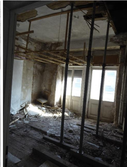
Abb.: altes Badezimmer im Obergeschoss Abb.: abgestützte Decken in Raum
