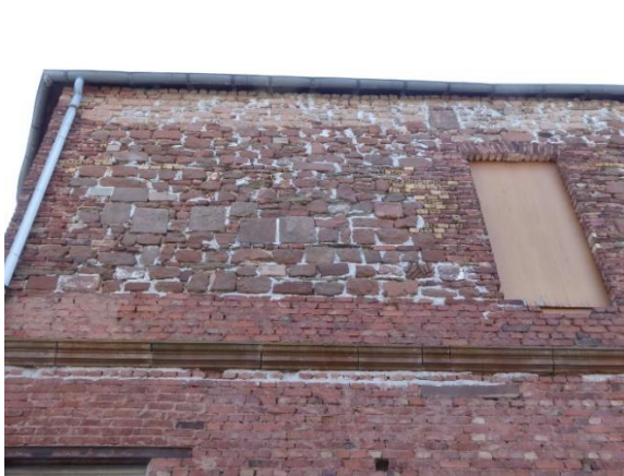
Abb.: Bruchsteinmauerwerk mit Spalten Abb.: alte Hangmauer mit tiefen Fugen
