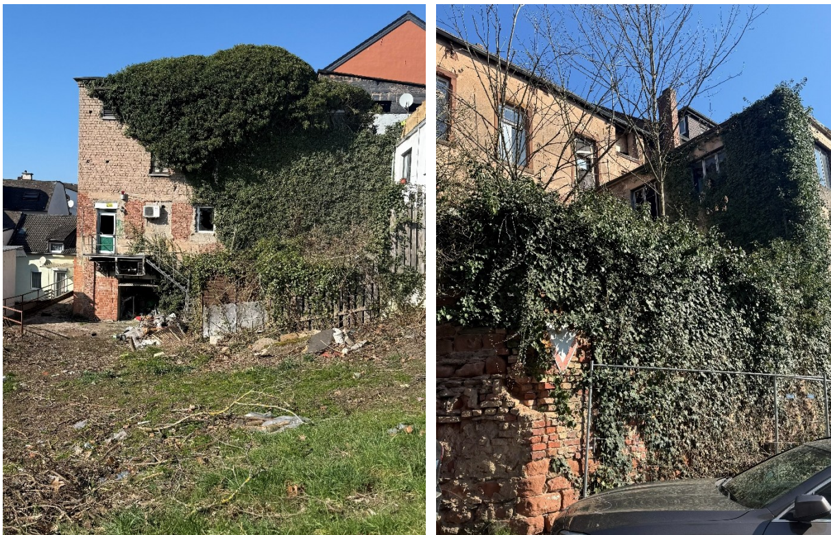
Abbildung 4: Wiesenfläche an der Gerberstraße (links), Efeubewuchs (rechts) (Fotos: Planung1, 2026)
