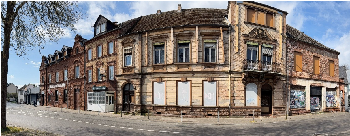
Abbildung 7: Gebäudefassade des Plangebietes (Panorama Foto: Planung1, 2025)
