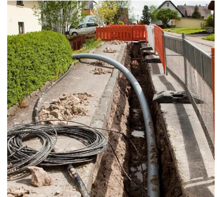
Platzsparender Rohrgraben
