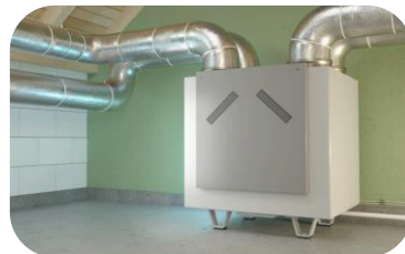
Wärmerückgewinnung (Luft)
