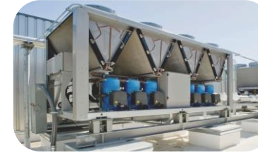
Abwärmenutzung aus Kälte
