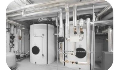
Rohrleitungsdämmung
