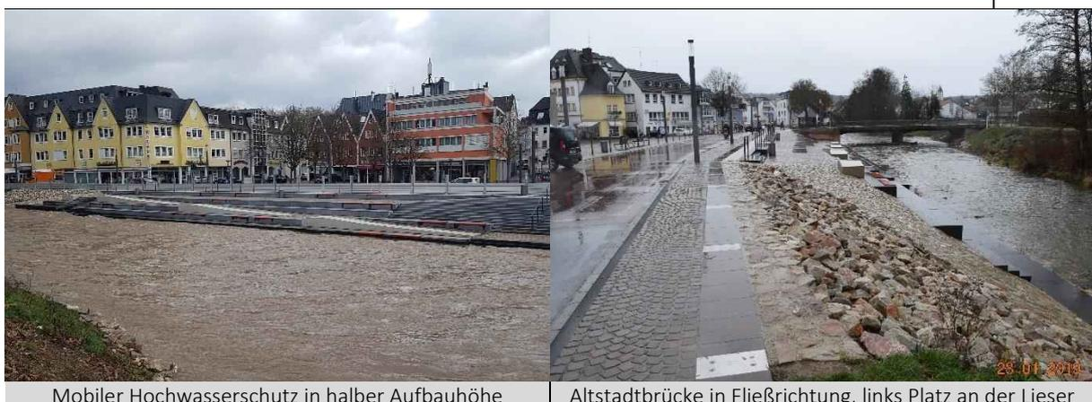
Mobiler Hochwasserschutz in halber Aufbauhöhe
