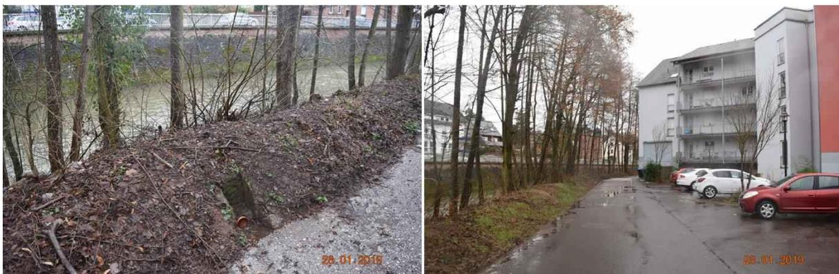
aufgeschütteten Verwaltung liegt und zudem der darin eingebaute Ablauf der Hofentwässerung nicht vor Lieserhochwasser geschützt ist. Dadurch kann das Hochwasser der Lieser bereits durch den Ablauf in den Hof einströmen (siehe Abb. 14). Hier ist die Hochwassersicherheit durch den Haus- bzw. Grundstückseigentümer herzustellen.
