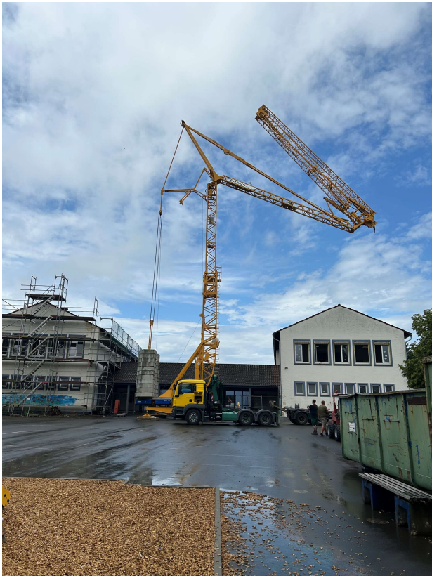
Ein 70t Kran, eins der Beton-Gewichte hinten drauf wiegt ca. 4 t.
