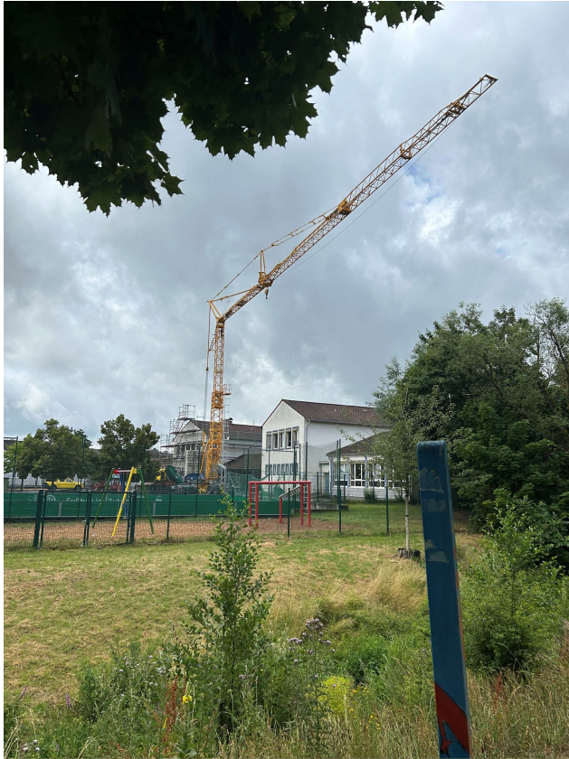
Ein 70t Kran, eins der Beton-Gewichte hinten drauf wiegt ca. 4 t.
