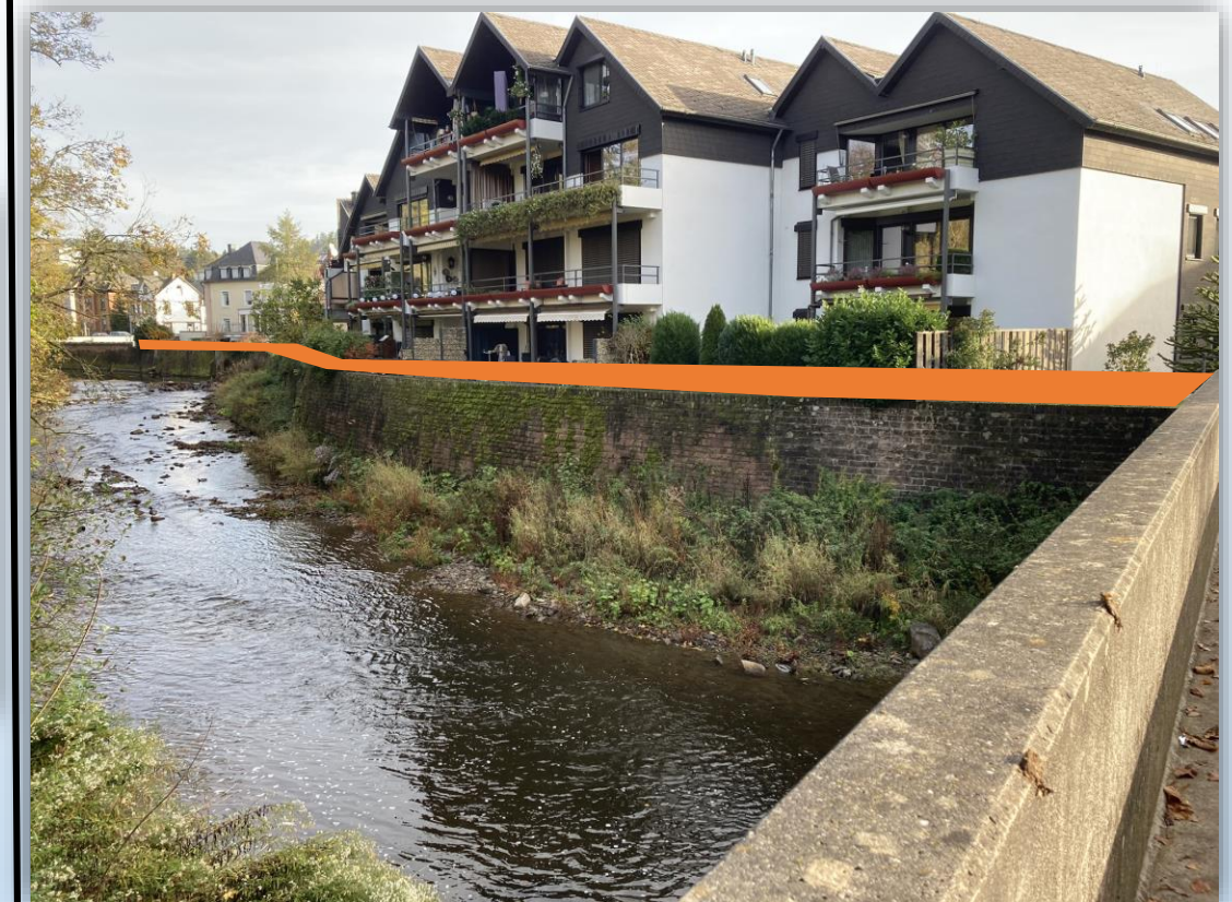
Maßnahme 2 – Hochwasserschutzmauer Schaffwehr
