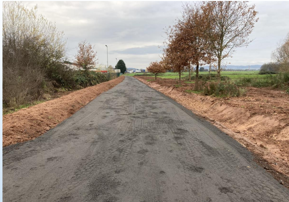
Fertigstellung – Nördlich der Belinger Straße
